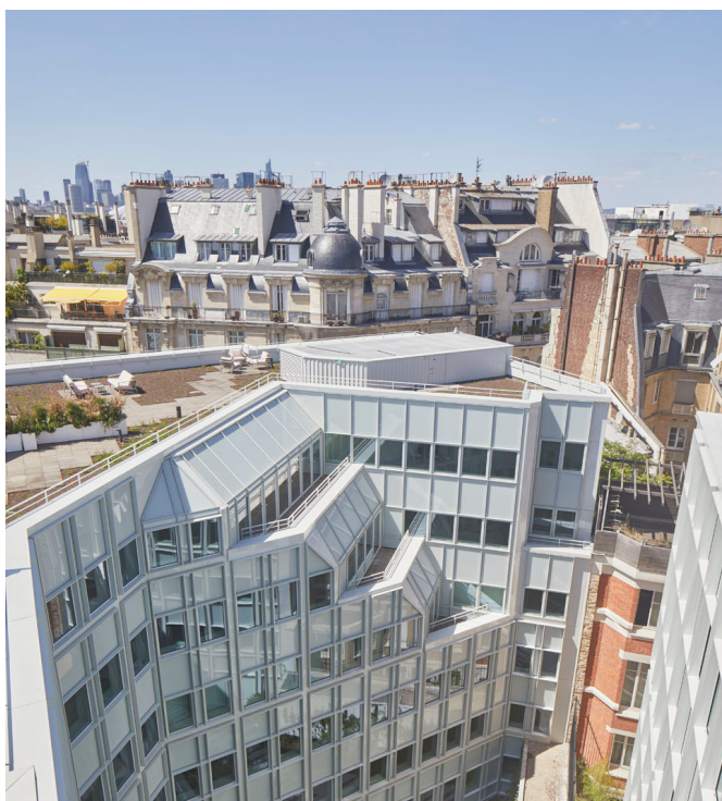
Figure 12 : Rénovation Belles Feuilles |Paris (75) | Basse Consommation | MO : Quartus | Architecte : DTACC
