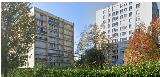
Figure 6 : Rénovation Basse Consommation Copropriétés Les Peupliers| Déville-les-Rouen (76) |MO : Cabinet Sauvage| Conseiller : ALTERN
