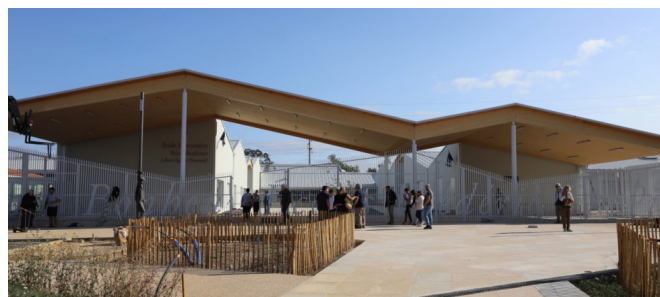
Figure 19 : Extension des écoles Rosa Bonheur et Frédéric Chopin |Bassens (33) | Bepos Effinergie 2017 | MOG Architectes |MO : Mairie de Bassens
