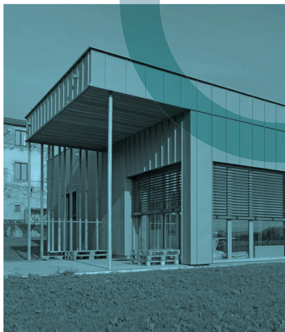
Pôle Petite Enfance | Bepos Effinergie 2023 | Architecte : MTA Architectes | MO : Communauté communes Couze Val d'Allier Crédit photo : Joël Damase
