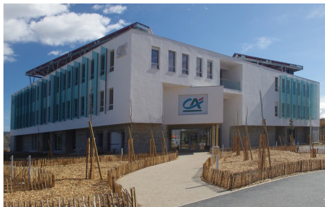
Figure 30 : Crédit Agricole PCA | Bepos Effinergie 2013 | Manosque (04) | Architecte : R+4 Architectes| MO : Crédit Agricole Provence Côte d'Azur
